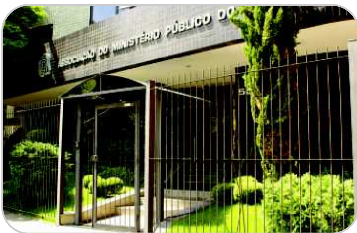
Segurança local: grades nas sedes administrativa
